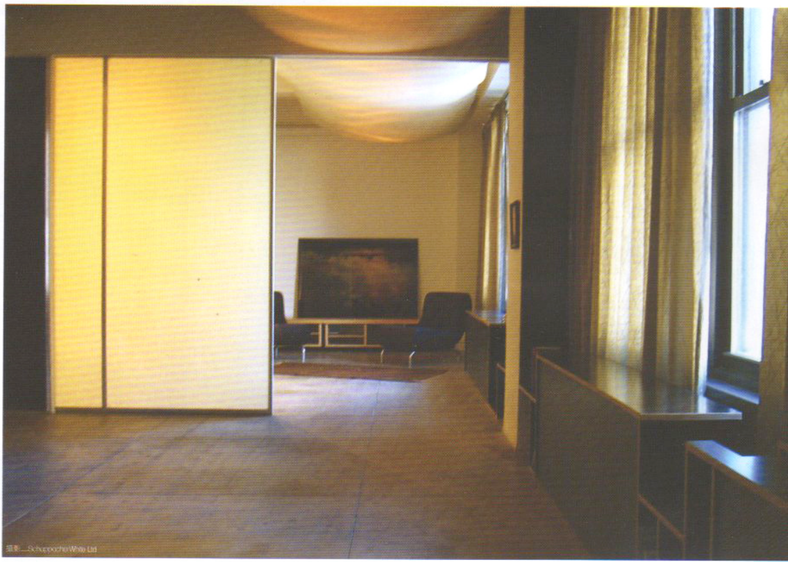
客廳與臥房之間的半透明拉門，運用的就是Panelite的材質，宛如硬化而更厚的氣泡紙般，光線可以自由進出，而且又不會像霧面玻璃沈重而易破。
